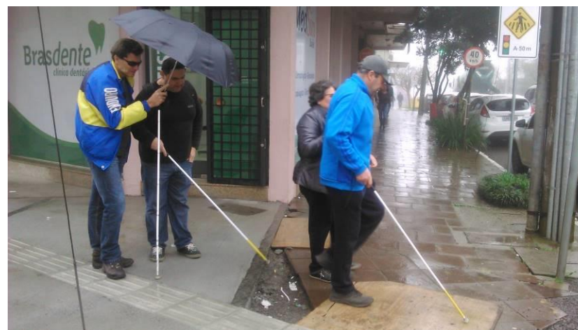
Obstáculos e defeitos nas calçadas
